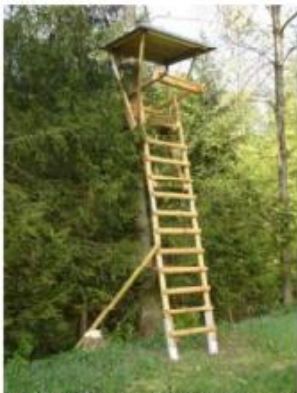
Einfache Jagdeinrichtung aus Holz (Ansztleiter), Befestigung mit Zurr Gurten am Baum, leicht und flexibel
